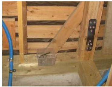
土台取替と柱継ぎ
