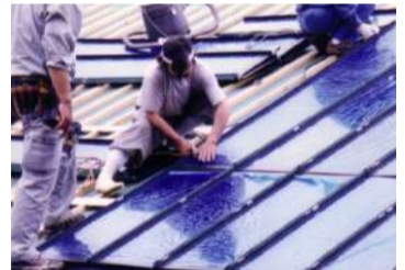
建材一体型太陽電池の取付け工事
