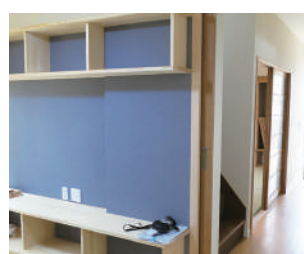
居間の収納(壁補強後)
